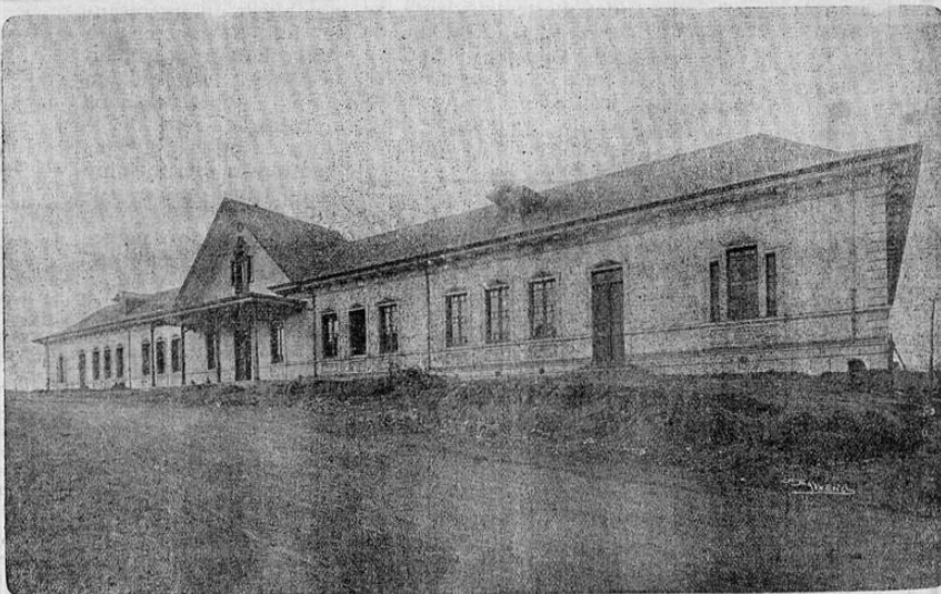
Edificio escolar de Aranjuez en esta capital
